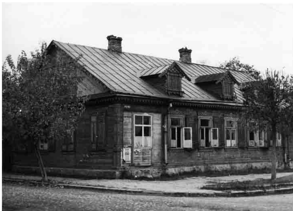
Ilustracja 1. Ulica 3 Maja nr 6. Siedziba byłego Powiatowego Tymczasowego Komitetu Rewolucyjnego Polski w Bielsku Podlaskim w 1920 r. Od 1944 r. w budynku mieściło się Państwowe Gimnazjum i Liceum Białoruskie. Obecnie obiekt przeznaczony jest na lokale usługowe. Zdjęcie wykonano najprawdopodobniej w latach 60. XX w. (z zasobu Archiwum Państwowego w Białymstoku, zespół: Komitet Wojewódzki Polskiej Zjednoczonej Partii Robotniczej w Białymstoku, nr zesp. 1070, sygnatura: 146/1).
